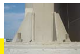
Монтаж металлической колонны к железобетонному основанию (резьбовая шпилька М 24, максимальная нагрузка на вырыв 136,6 кН)
