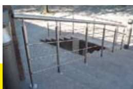
Крепление перил из нержавеющей стали (минимальное расстояние от края, не вызывает растрескивания декоративного камня)
