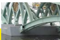
Крепление элементов несущих конструкций моста
